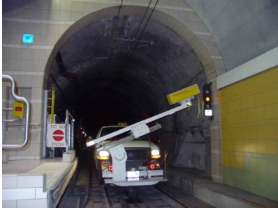
System med luftkopplad antenn
